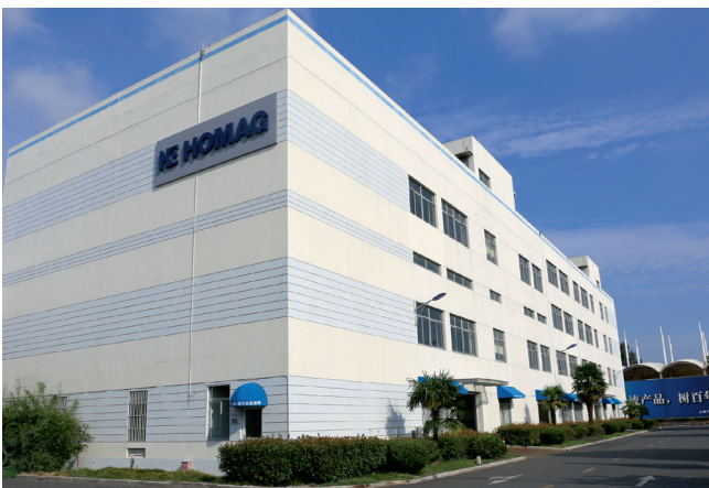
上海工厂办公楼
